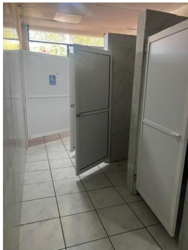
Remodelación de los sanitarios
